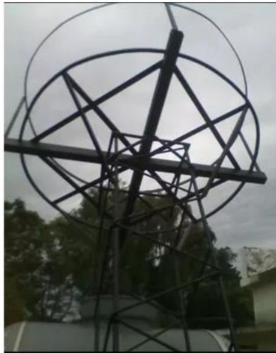
Figura 7.2 Torre para elevamiento de tanque de agua
