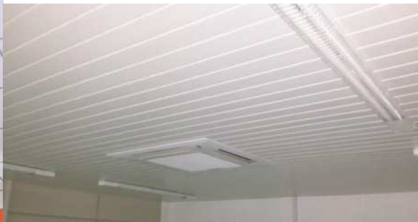
Fig. 14. Cielorraso de PVC
