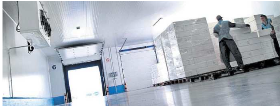
Fig. 9. Piso de cámara frigorífica
