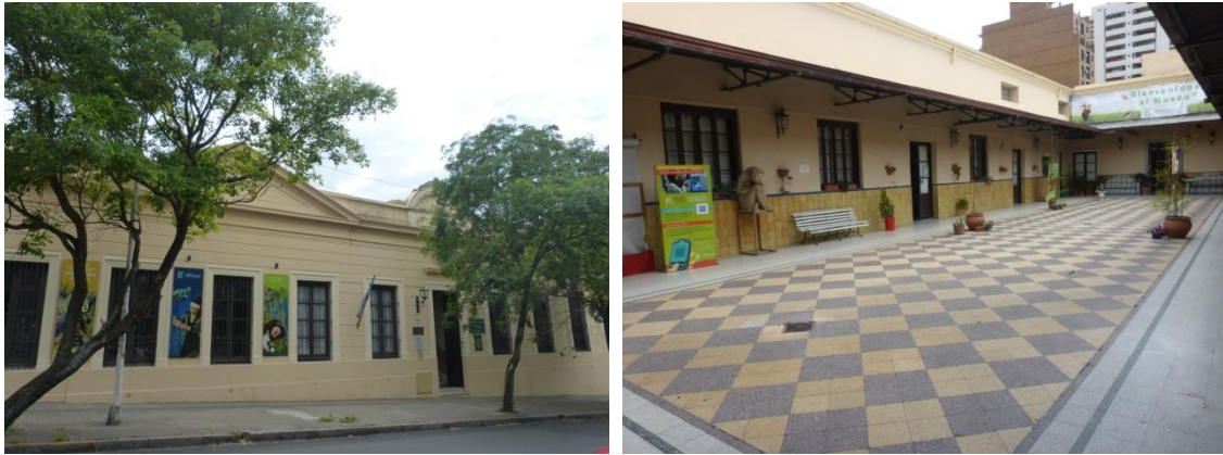
Figura 3. De izquierda a derecha, fachada y patio interno.
